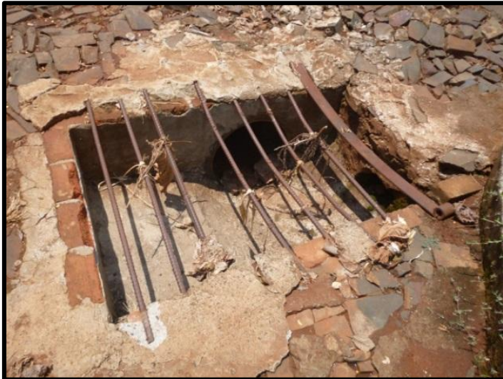
Figura 7: Estruturas de drenagem identificadas em campo.
